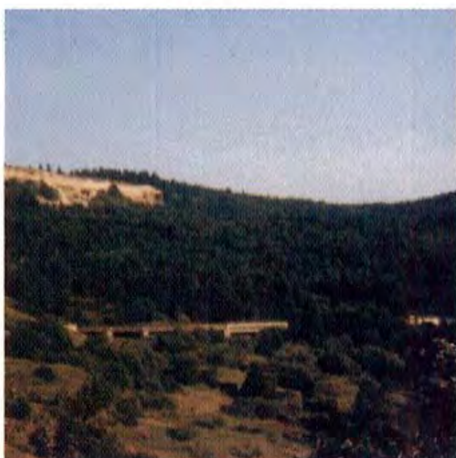
Pfeiler u. Brücken am Trauf
